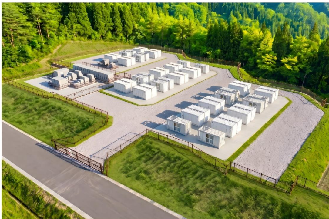
木島平 蓄電所建設工事全体イメージ
