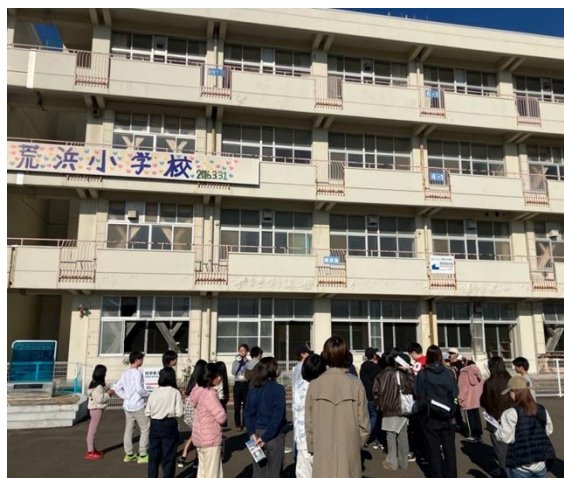
震災遺構 仙台市立荒浜小学校
