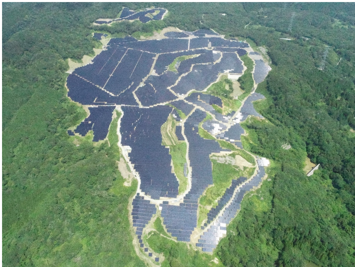
(画像：石川沢川太陽光発電所)
