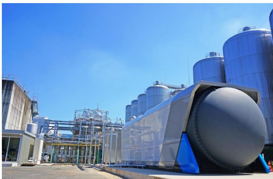
アサヒビール茨城工場に導入した設備全体 (左奥：工場排水処理設備、中央：バイオガス精製設備、右手前：SOFC)
