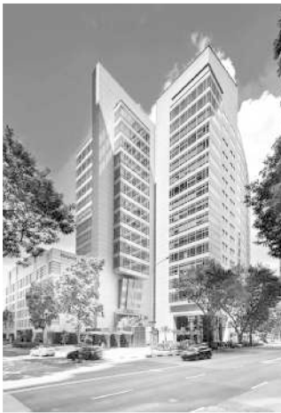
投資したシンガポール中心部のオフィスビル
