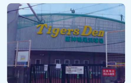
SMARTが解体工事を請け負った阪神鳴尾浜球場
